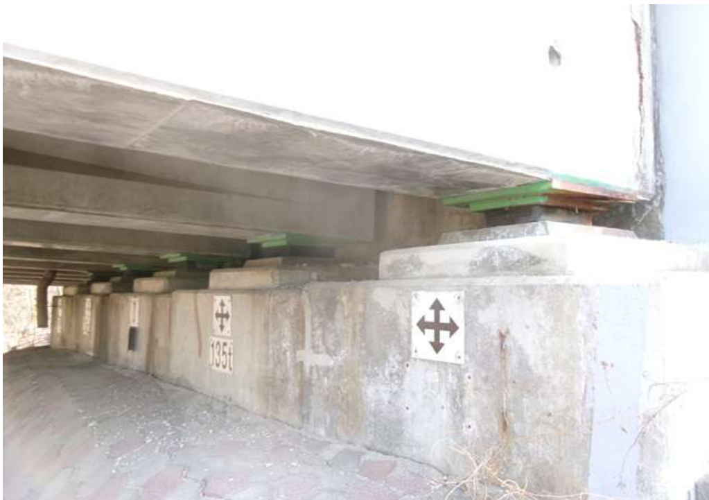
사능1교(하) 교대 전경
